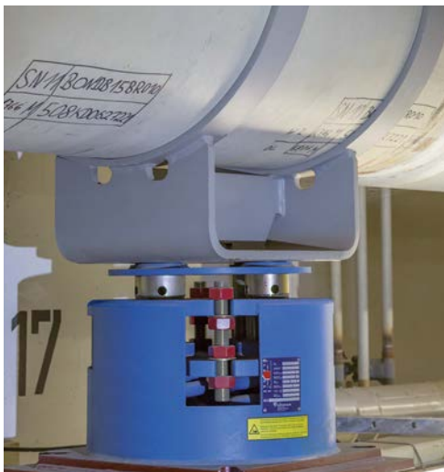
Patín con abrazadera tipo 49 y soporte de carga variable tipo 28 con placas deslizantes
