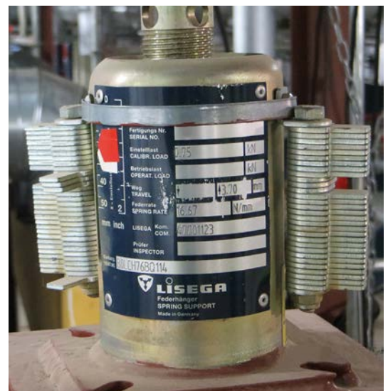
Tipo 29 con dispositivos de bloqueo acoplados
