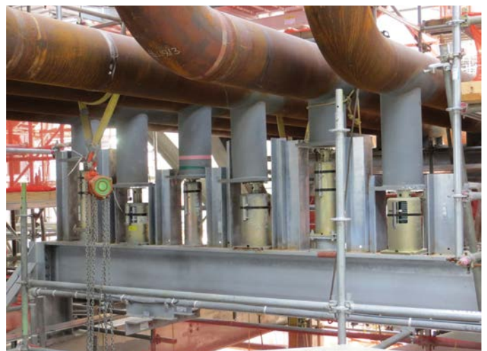
Stanchion tipo 58 utilizados como guías para sistemas de tuberías horizontales con soporte de carga variable tipo 29
