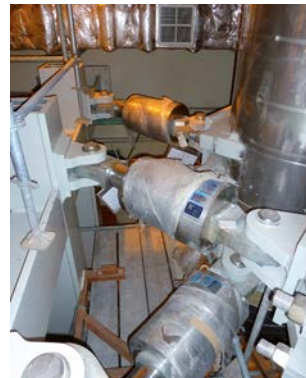
Sujeción de sistemas de tuberías con amortiguadores hidráulicos tipo 30
