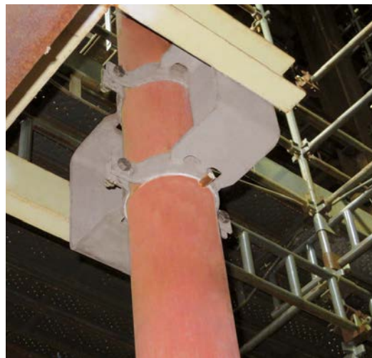
Soporte de tubería (tipo 49 ... G2P)
